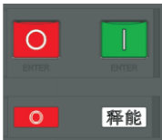
断路器断开且无储能状态
