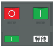
断路器合闸且无储能状态
