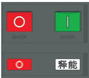
断路器断开且无储能状态
