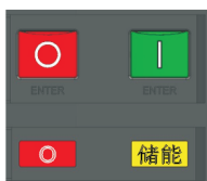
断路器断开且已储能完毕状态
