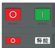
断路器断开且无储能状态
