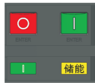
断路器合闸且已储能完毕状态
