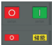
断路器断开且已储能完毕状态
