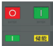
断路器合闸且已储能完毕状态
