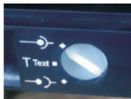
在“连接”位置，主电路及二次回路均接通
