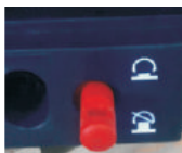
在“分离”、“试验”、“连接”三位置时，位置锁锁定，摇柄无法操作(锁定状态)
